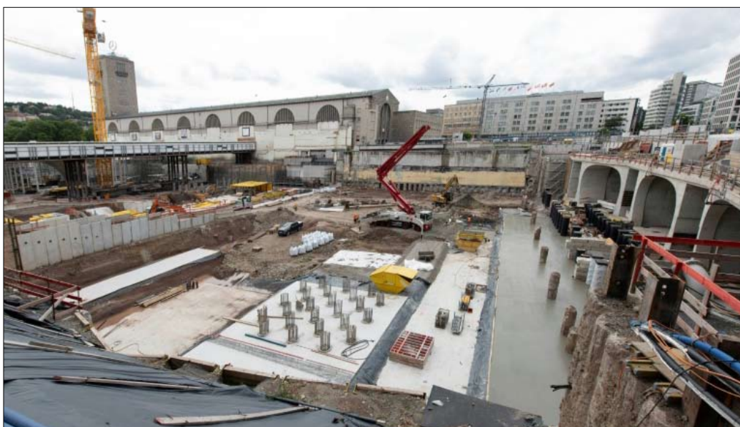
مبنى جديد قيد الإنشاء في منطقة عجمان الحرة.
